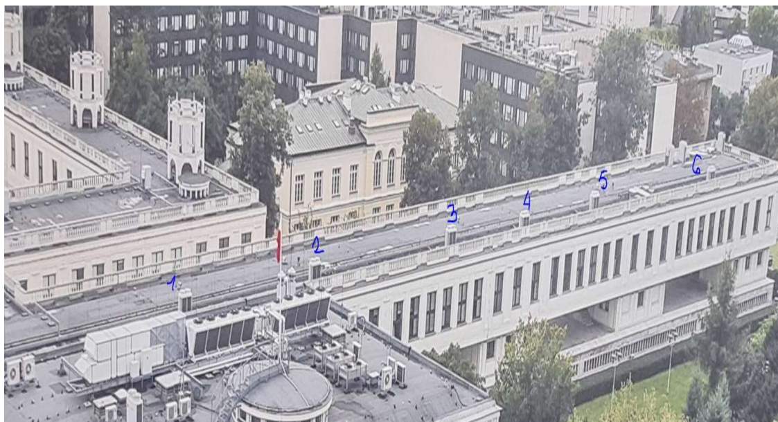
Dach budynku „B” z lokalizacją jednostek zewnętrznych istniejących układów klimatyzacyjnych.
