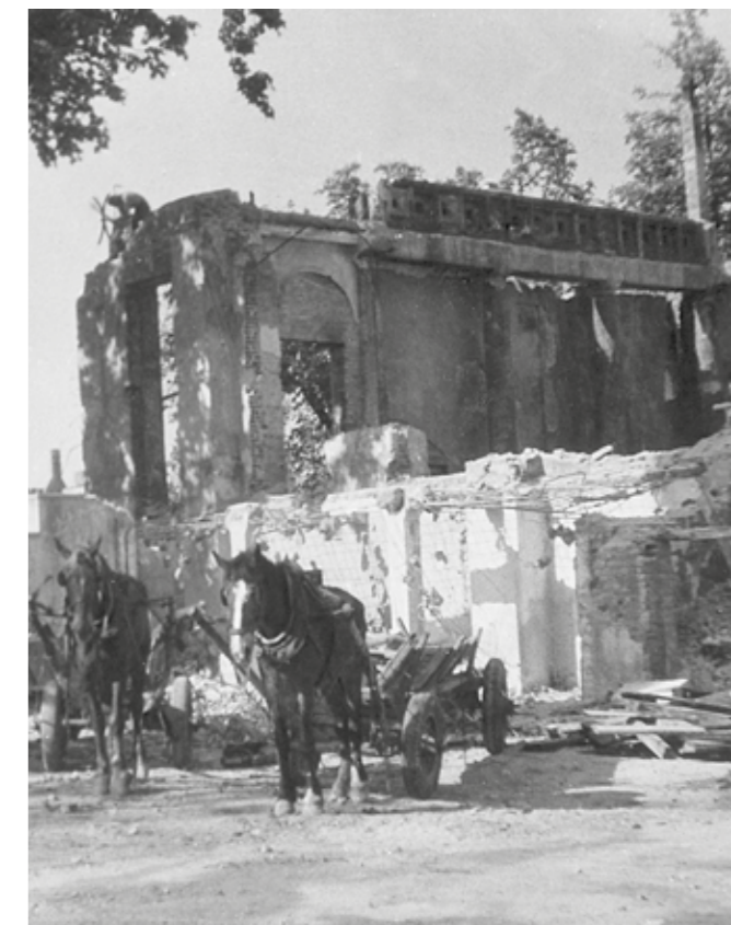
Ryc. 55 Rozbiórka skrzydła, które do 1939 r. zajmowała Sala Posiedzeń Senatu, lato 1946 r.
