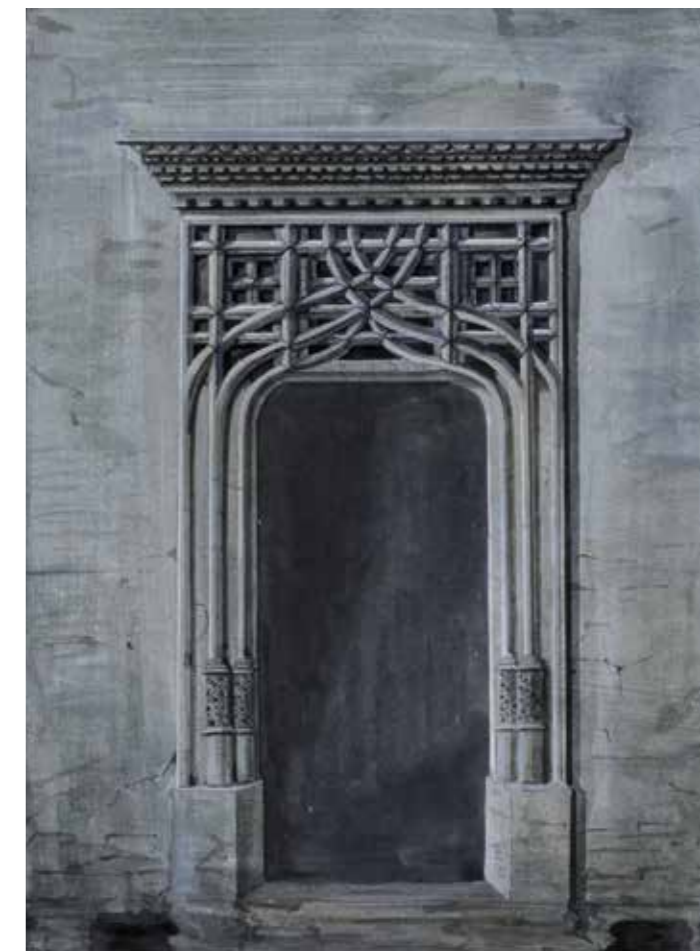
Ryc. 7 Portal zamkowy w sali na pierwszym piętrze, stan w I połowie XIX w.
