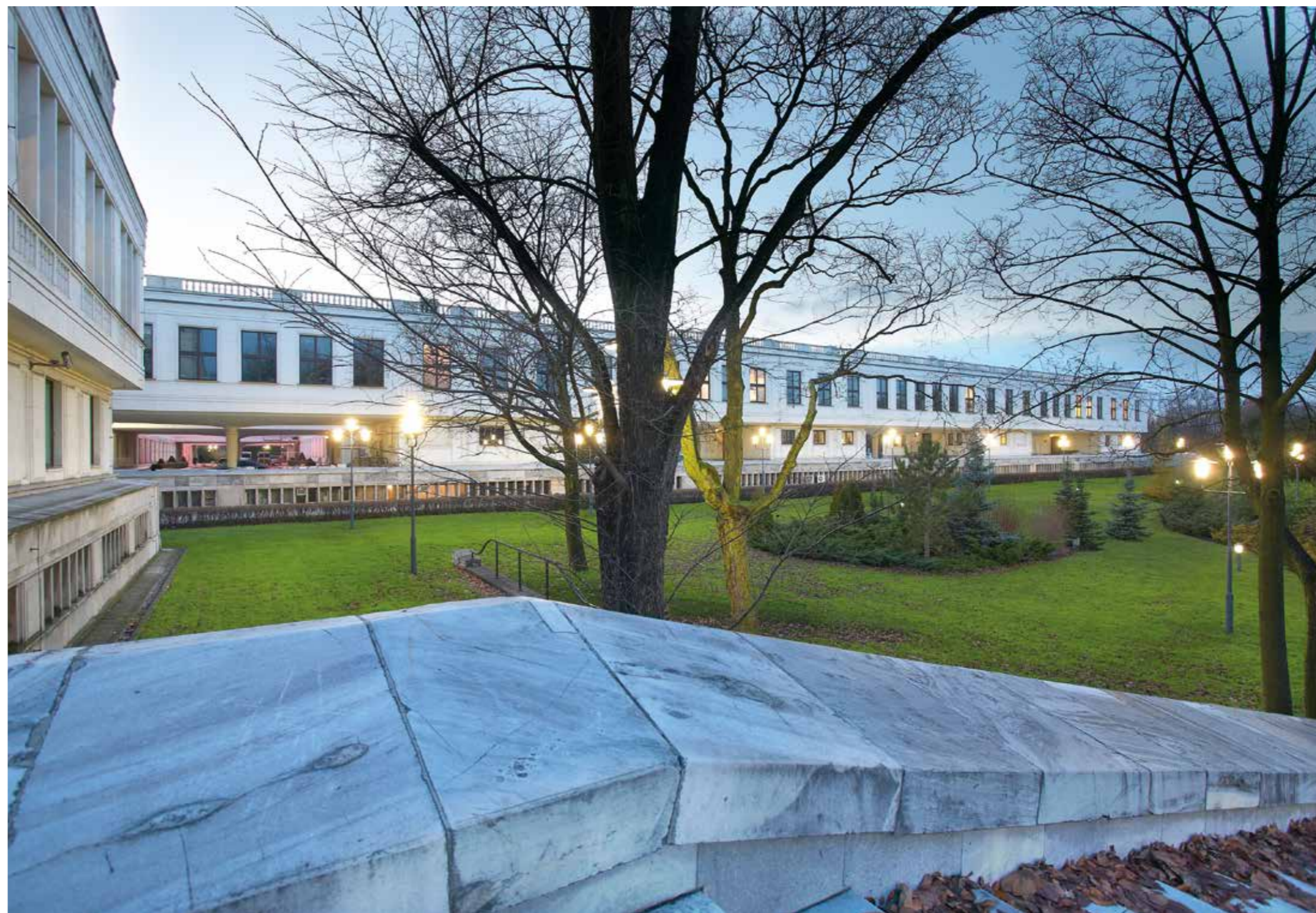
Ryc. 57 Widok na budynki A i B od wschodu, czyli od strony skarpy, stan obecny
